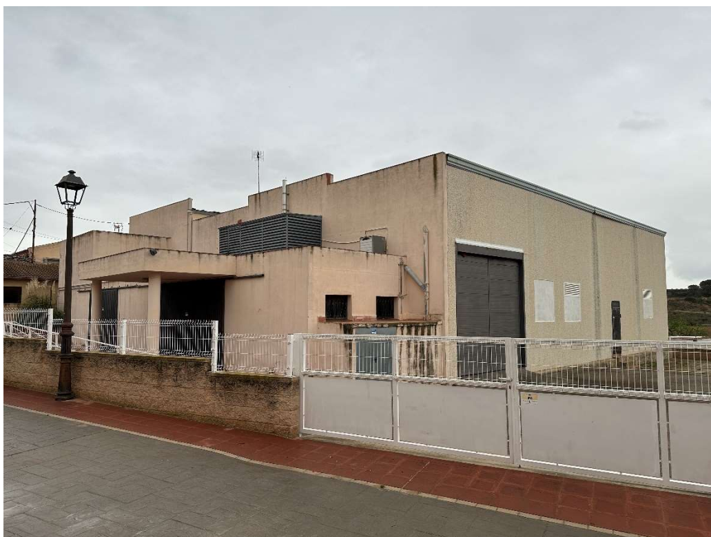
Façanes principal i lateral del Casal Cultural d'Alió
