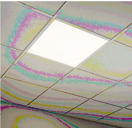
6. Fals sostre registrable acabat vinílic
