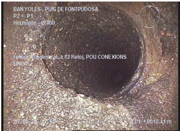
P2-P1_f575a010-3aae-4010-9402-1c47d725c5cd_20250507_180015_797.jpg, 00:01:22, 10.40m Fotografía general, a 12 Reloj
