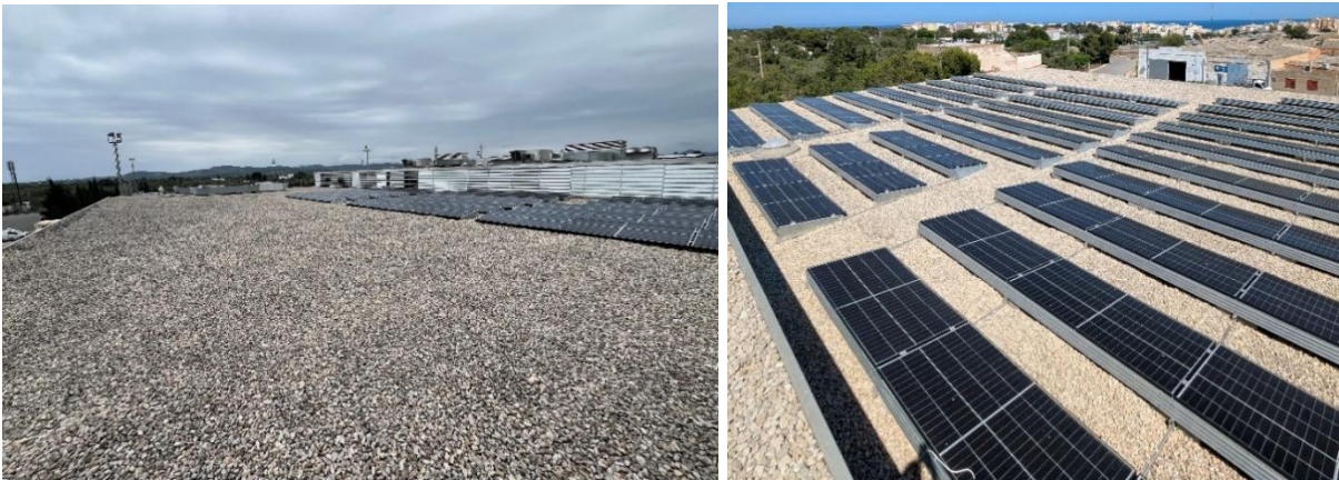
Coberta CEM La Cala
