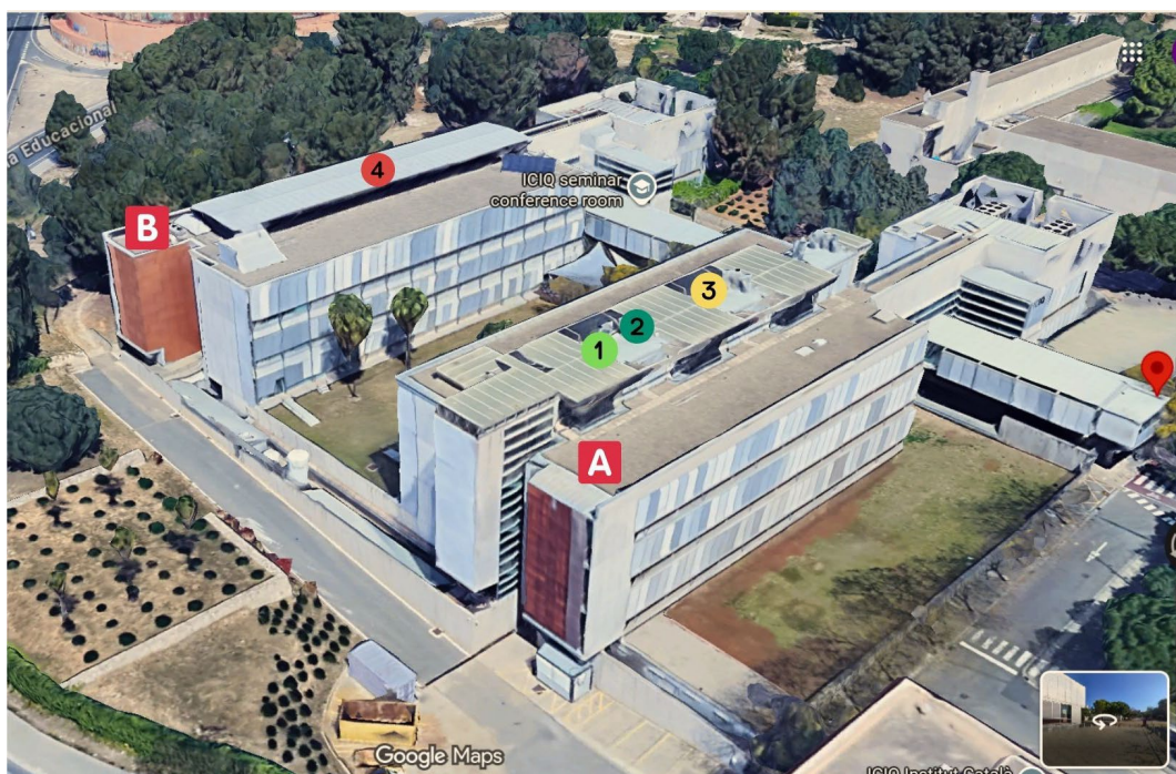
Imatge 1: Punts d'elevació i descàrrega de material i instal·lació dels sistemes de tractament.
