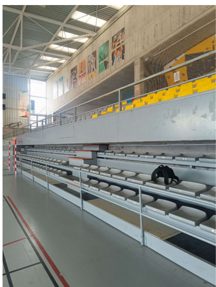
vista detall grada interior
