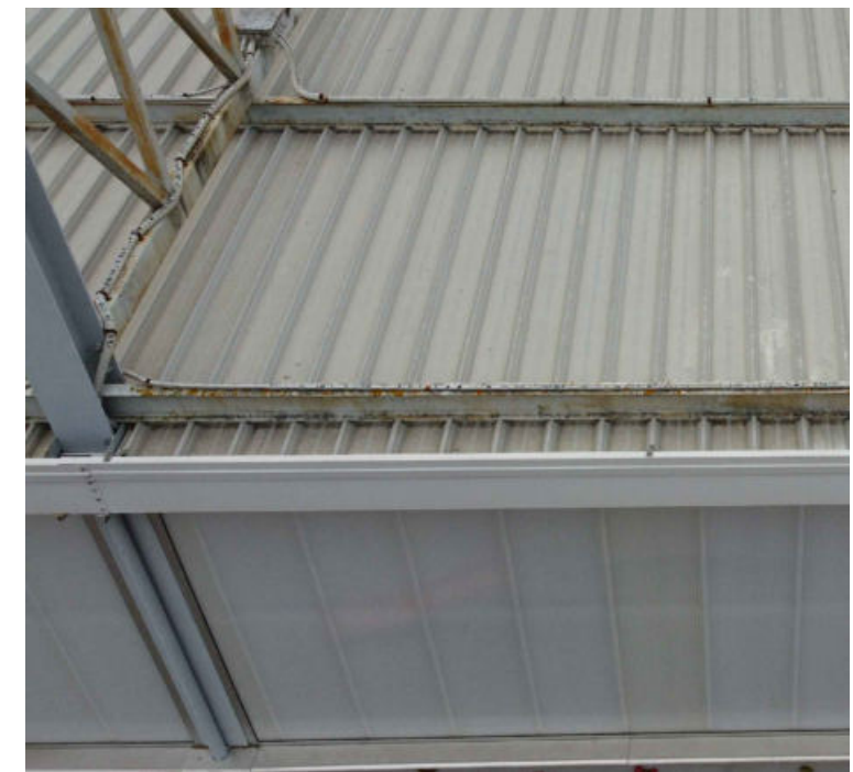
TIPOLOGIA DE COBERTA - PANELL SÀNDVITX
