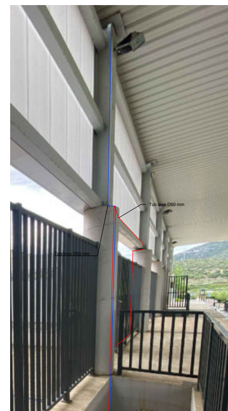
ESQUEMA CABLEJAT DE CC I AC (2)
