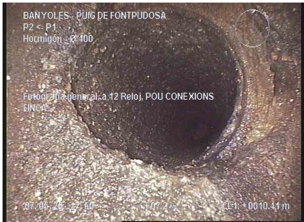
P2-P1_f575a010-3aae-4010-9402-1c47d725c5cd_20250507_180015_797.jpg, 00:01:22, 10.40m Fotografía general, a 12 Reloj
