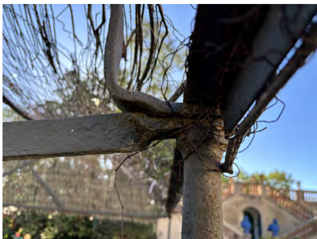
Imatges 240419-21 i 30. Exemples de trencaments de subjeccions, de deformacions de trams, i d'oxidació superficial de diverses seccions.
