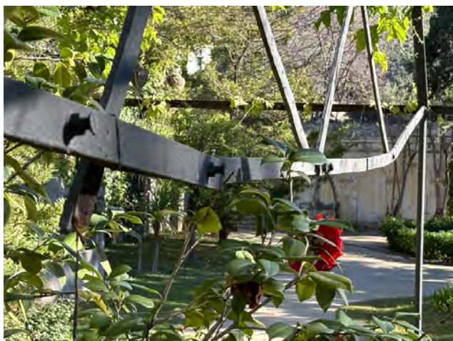
Imatges 240419-21 i 30. Exemples de trencaments de subjeccions, de deformacions de trams, i d'oxidació superficial de diverses seccions.
