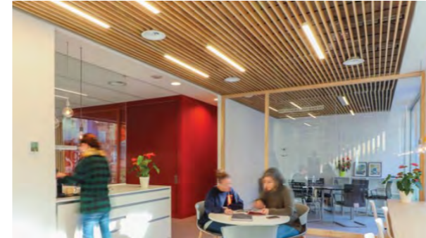
LF SOSTRE ACÚSTIC AMB REVESTIMENT DE LAMES DE FUSTA REF: Mod. T-8_20_50_55. SPIGOLINE
