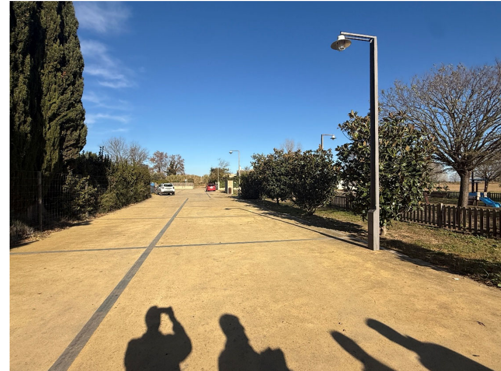
Figura 9. Carrer del Clos, paviment amb formigó
