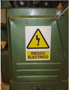
Foto 06: Tots els riscos elèctrics estaran degudament senyalitzats
