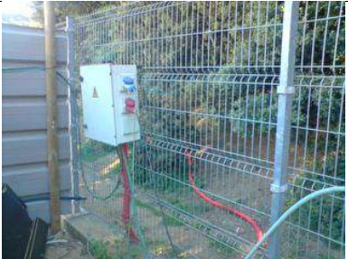
Foto 06: Tindrem cura de les instal·lacions provisionals d'obra.
