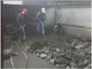
Foto 02: En tot moment els operaris portaran els E.P.I.'s necessaris pels treballs
