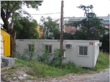
Foto 04: Abans inici obra s'instal·laran les casetes d'obra.
