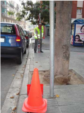
Foto 01: Abans d'iniciar els treballs d'obra, es realitzarà una comprovació de serveis amb el radiodetector i receptor de senyals.
