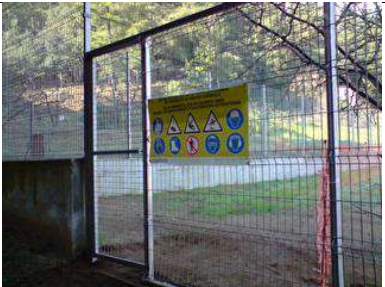
Foto 02: Es col·locarà senyalització d'obres en tots els accessos.
