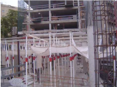
Foto 01: Sota l'estructura d'encofrat realitzarem una protecció horitzontal per evitar caigudes a diferent nivell en treballs d'encofrat.
