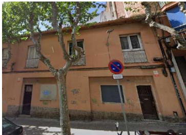
Fotografia 4: Accés secundari pel carrer de la Plaça
