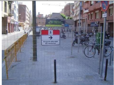
Foto 03: Les zones exteriors d'obra estaran degudament senyalitzades
