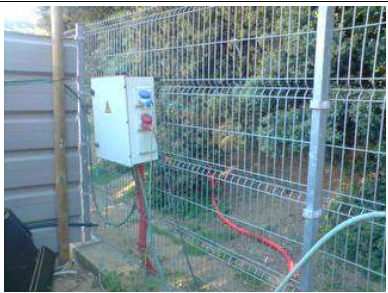
Foto 05: Tindrem cura de les instal·lacions provisionals d'obra.
