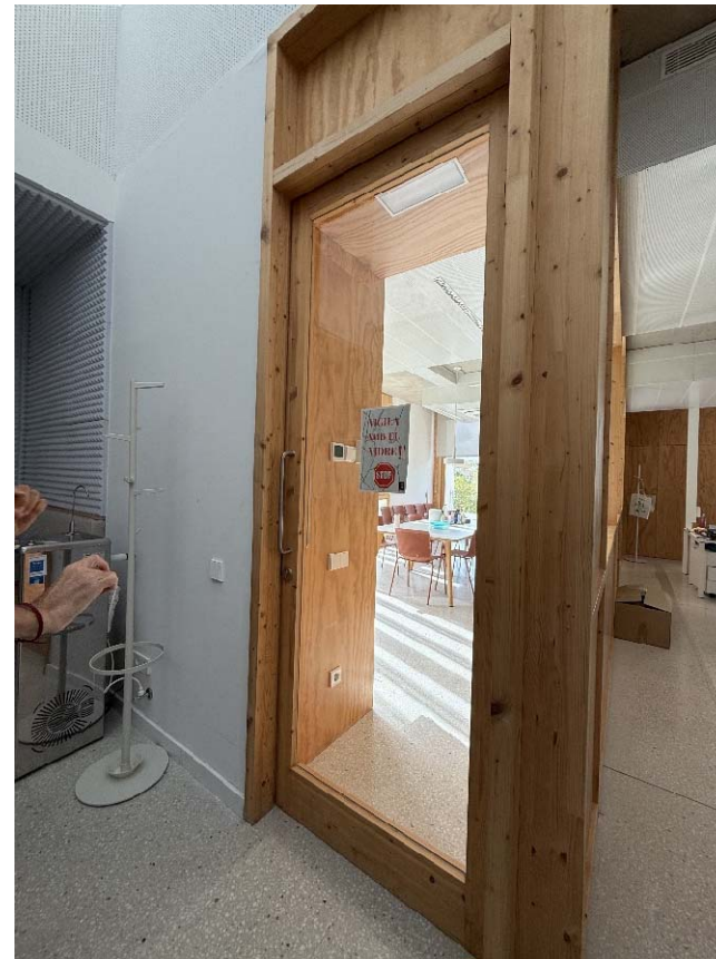
PORTA EXISTENT DE L'ESPAI 9.3 (SALA OFFICE) P2
