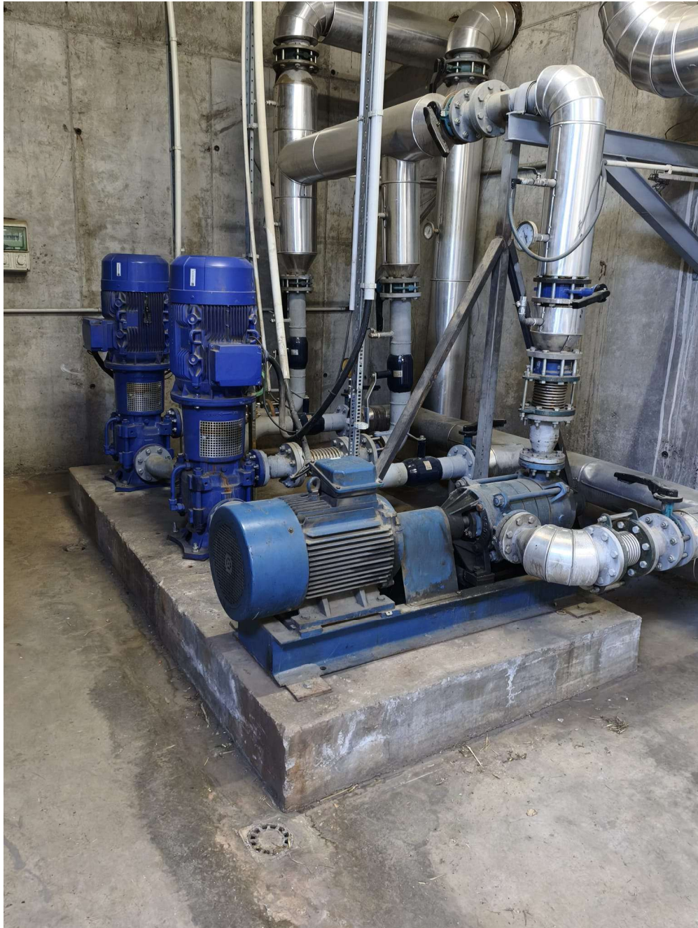
Estat actual, amb la bomba horitzontal a substituir en primer pla
