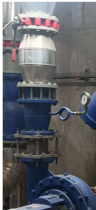
Detall elements canonada d'aspiració i impulsió de la bomba
