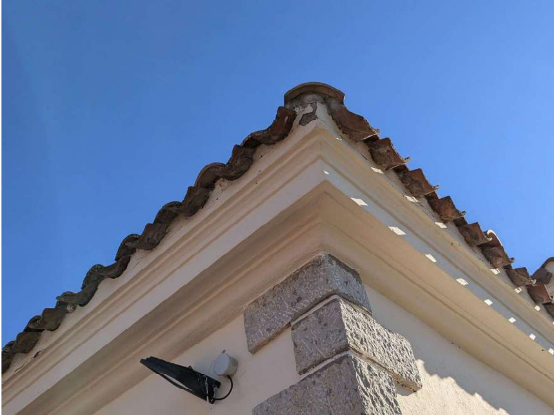
Detall del ràfec de la coberta
