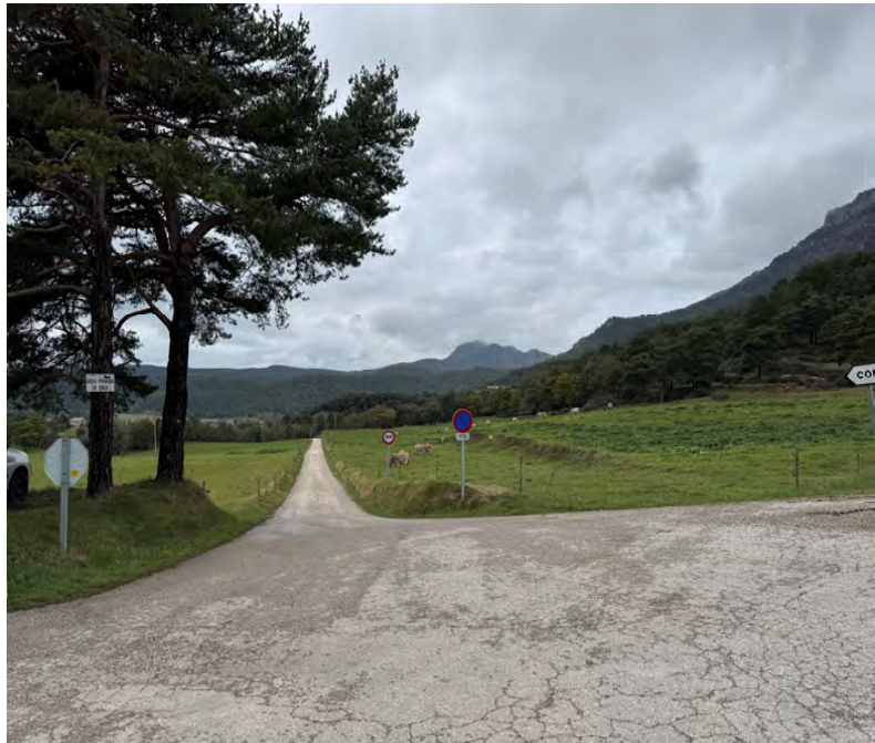
Trobada amb la carretera BV-4241 al Km 5,85.
