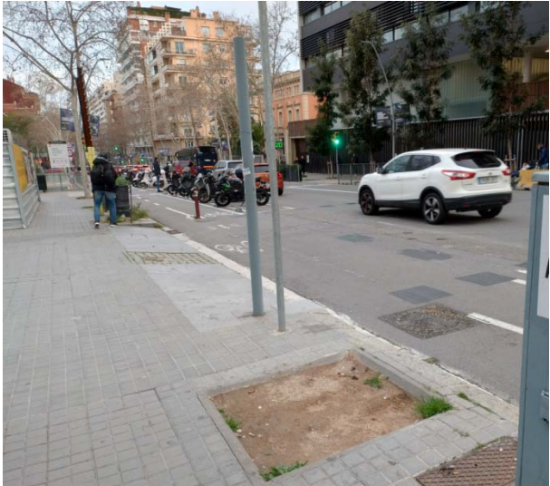
Vorera costat Besòs
