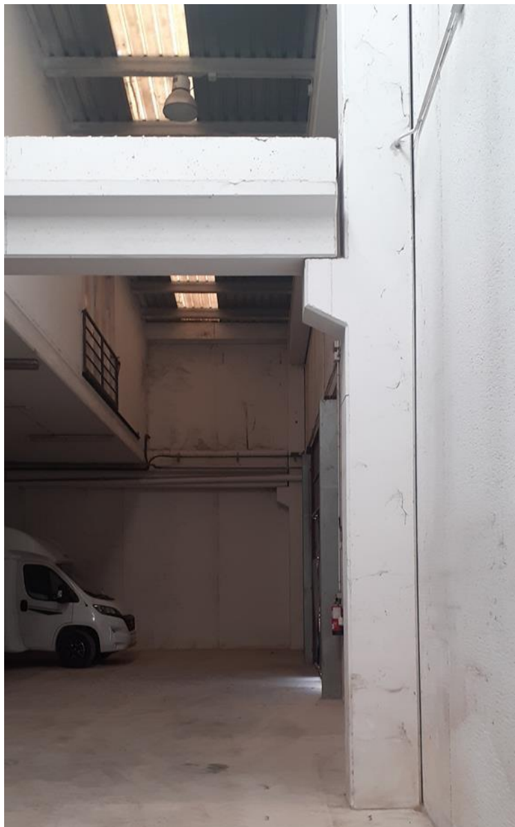
Foto 04. Interior de la nau per la nova ubicació de la brigada municipal en PB
