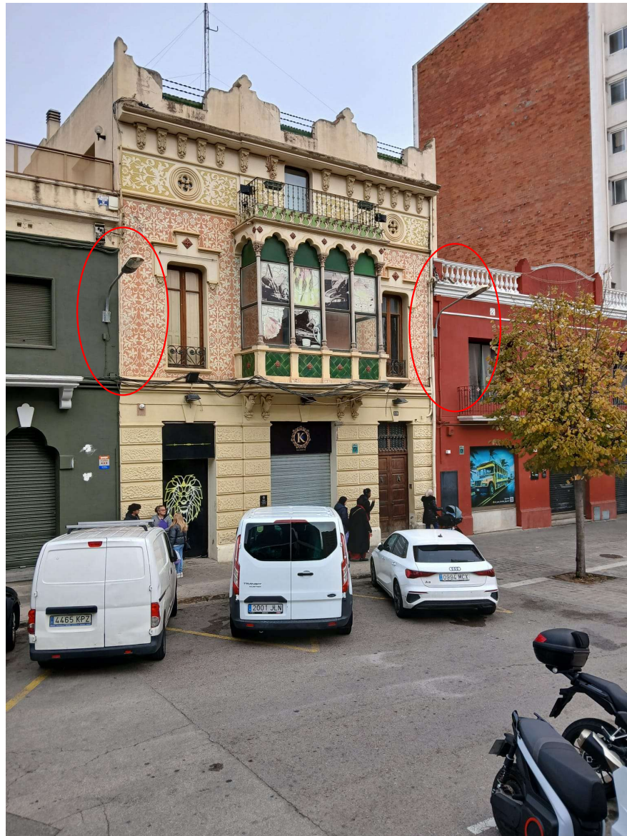
Imatge 5. Sector plaça del Sol façanes edificis – tipologia existent
