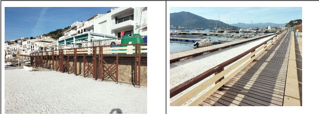
Estat actual barana
