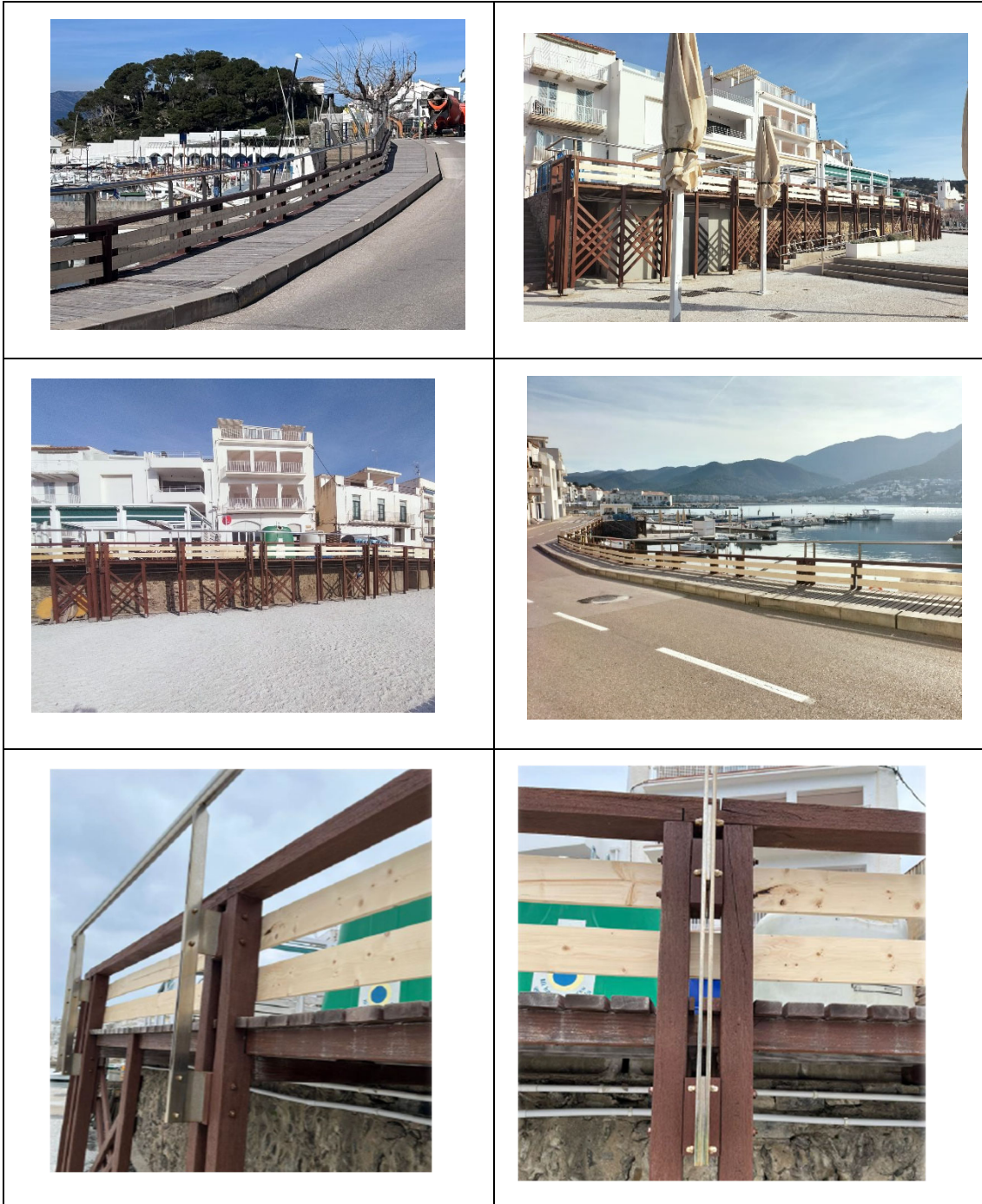
Trams amb taulons i estructura acer a retirar
