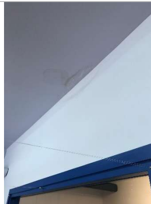
Filtracions de coberta en zones de conductes de ventilació.
