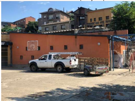
Façana Oest mòdul 2 (Menjador)
