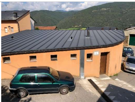
Coberta – Façana sud est.
