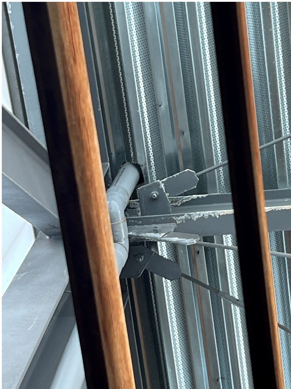
Figura 18:Eflorescències en els perfils
