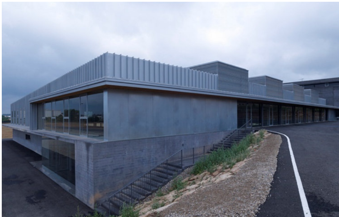
Figura 1: Imatge actual exterior del pavelló Juanjo Garra (orientació sud-est)
