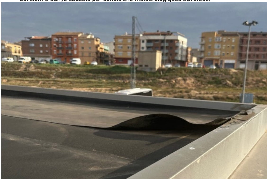
Figura 15: Vista general de la coberta superior
