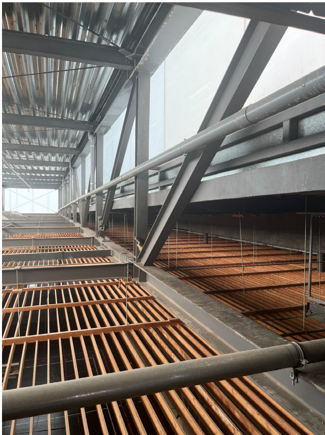
Figura 22: Vista general del cel ras de fusta i de les instal·lacions
