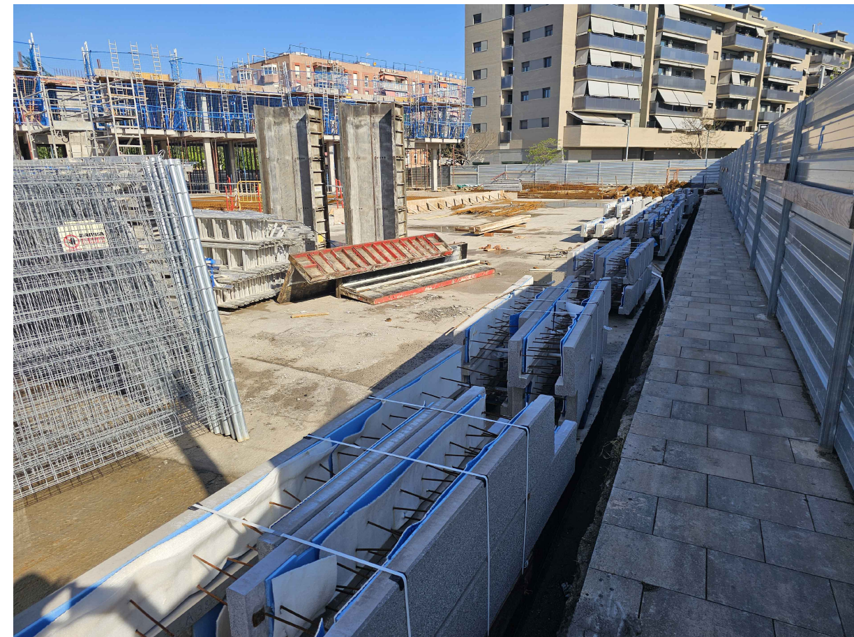
V.3 Obres d'execució de l'aparcament soterrat
