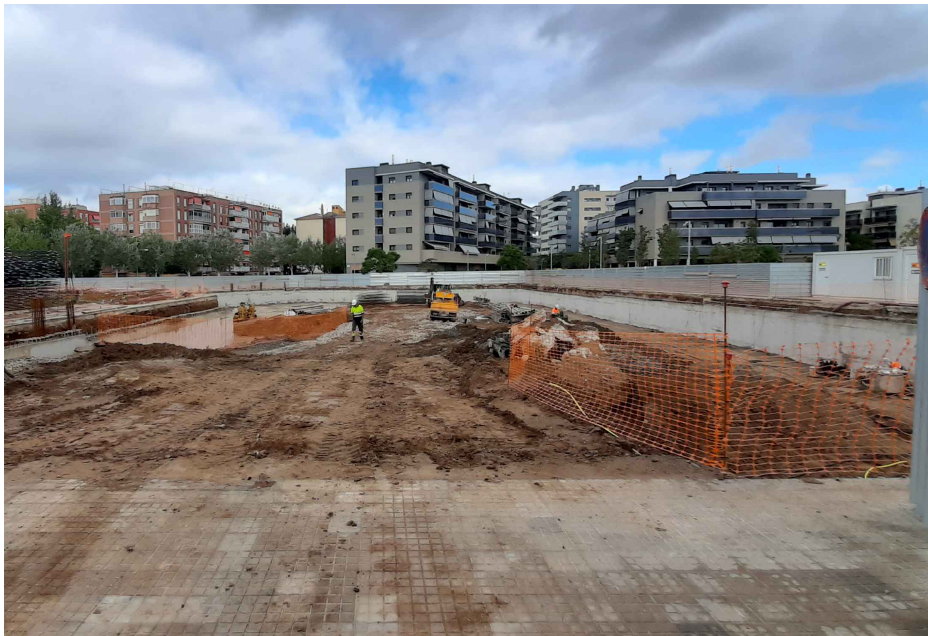
V.2 Obres d'execució de l'aparcament soterrat
