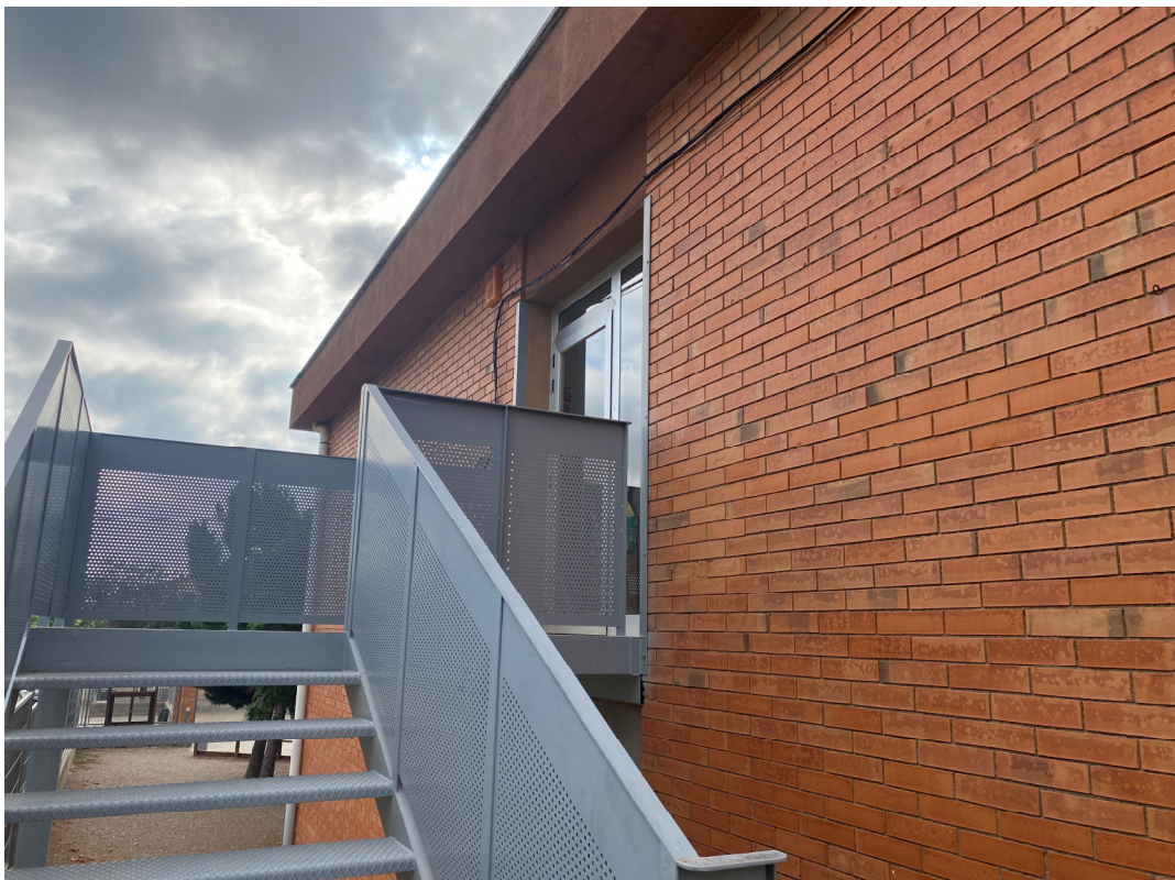
D.F.4 Accés des de l'exterior en planta primera per s'arribarà a l'ascensor.
