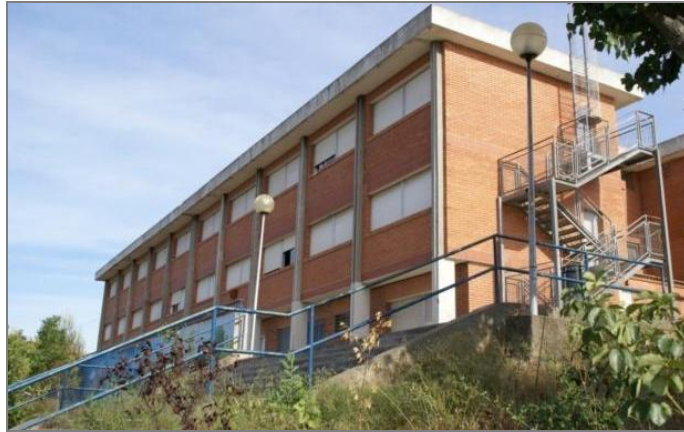
Façana principal de l'escola
