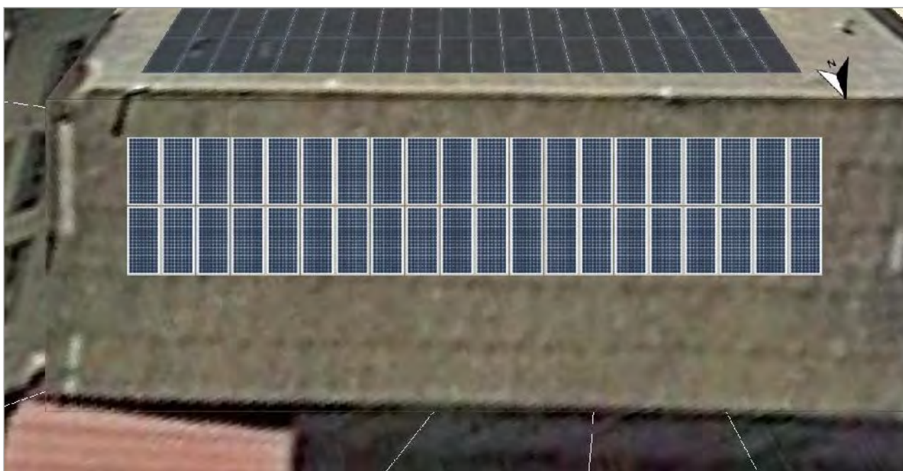
Figura: 1. Superficie fotovoltaica - Edificio 02-Superficie del tejado norte
