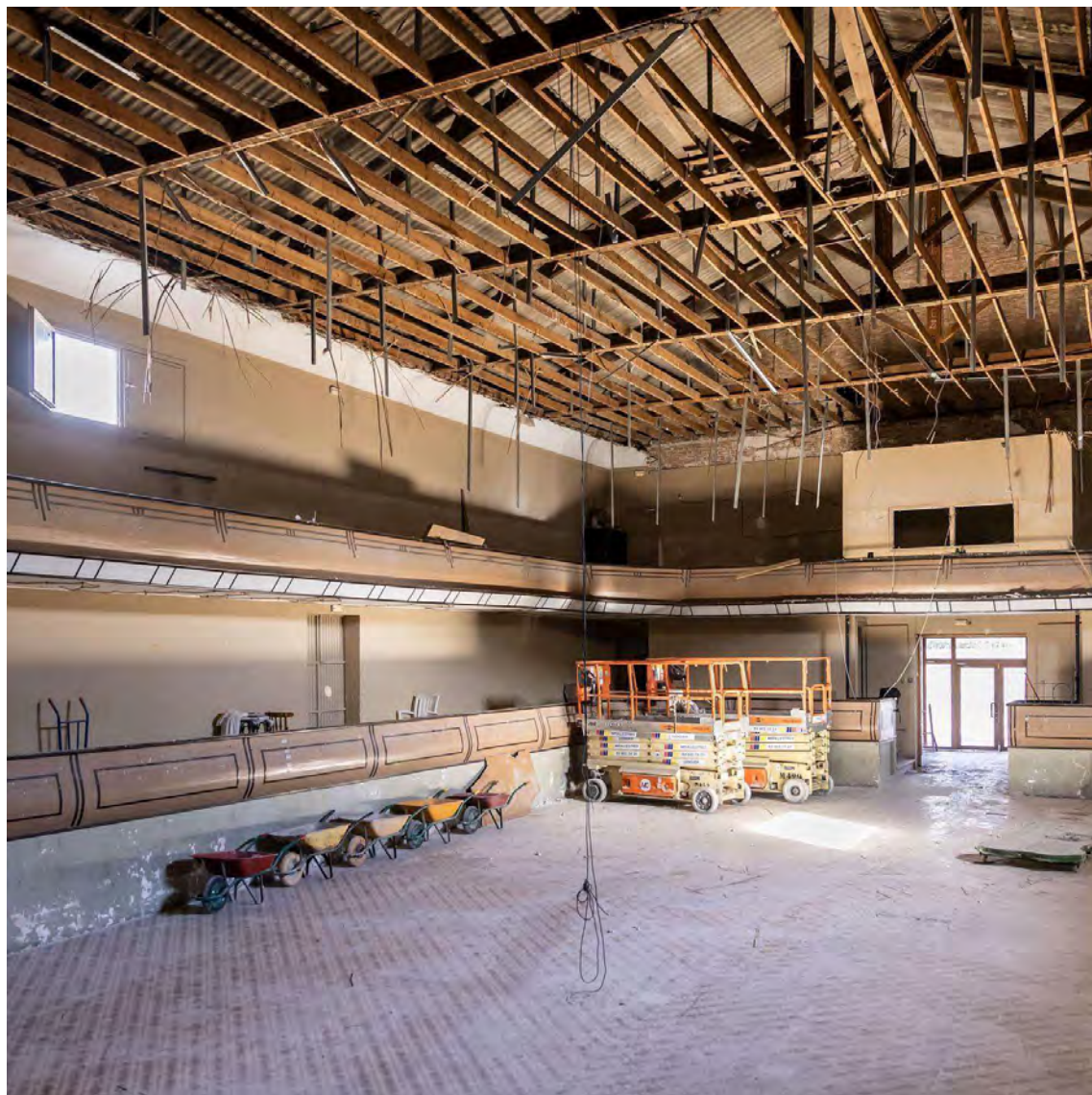
Foto 4. Vista interior. Zona accés
