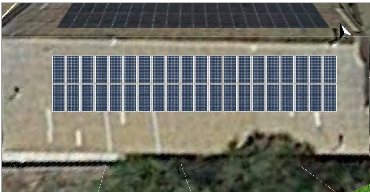
Figura: 2. Superficie fotovoltaica - Edificio 02-Superficie del tejado sur
