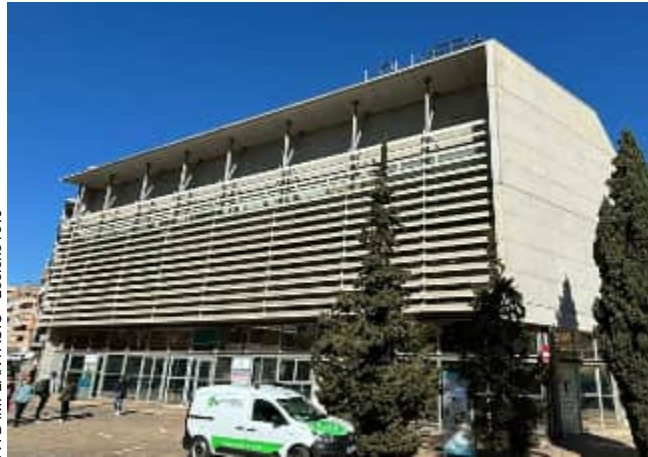
PB.3 Façana sud amb Carrer de Joan Pagès (entrada)
