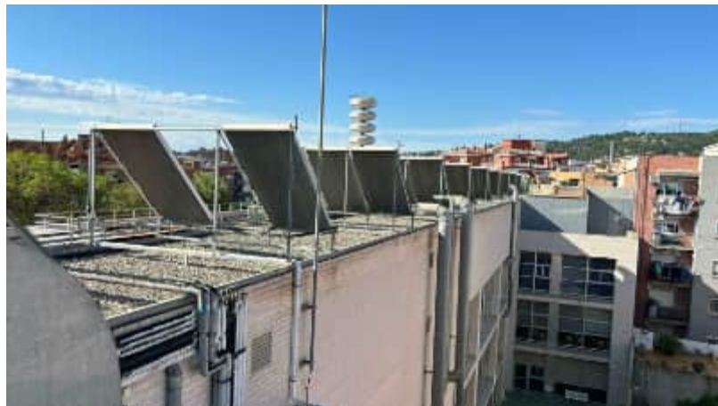
PC.3 Vista general, estat actual badalot amb plaques fotovoltaica
