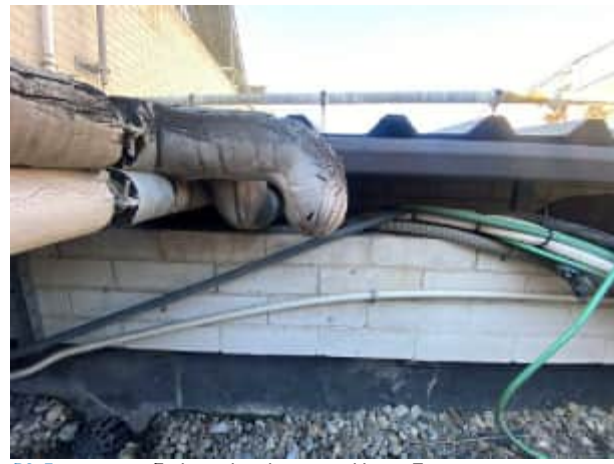
P3.7 Embornal malament col·locat. Taponament per graves
