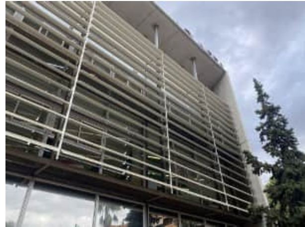
PB.3 Façana sud amb Carrer de Joan Pagès (protecció solar)
