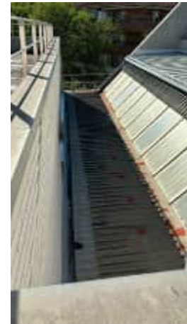
P3.5 Esquerda en façana de pati
