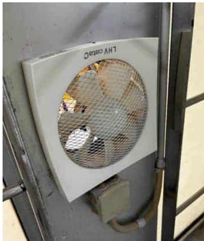
Foto 8: Extractor d'un dels vestuaris del poliesportiu de l'Olivera
