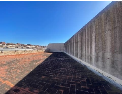
Figura 19: Mur de formigó vist al costat sud de la coberta
