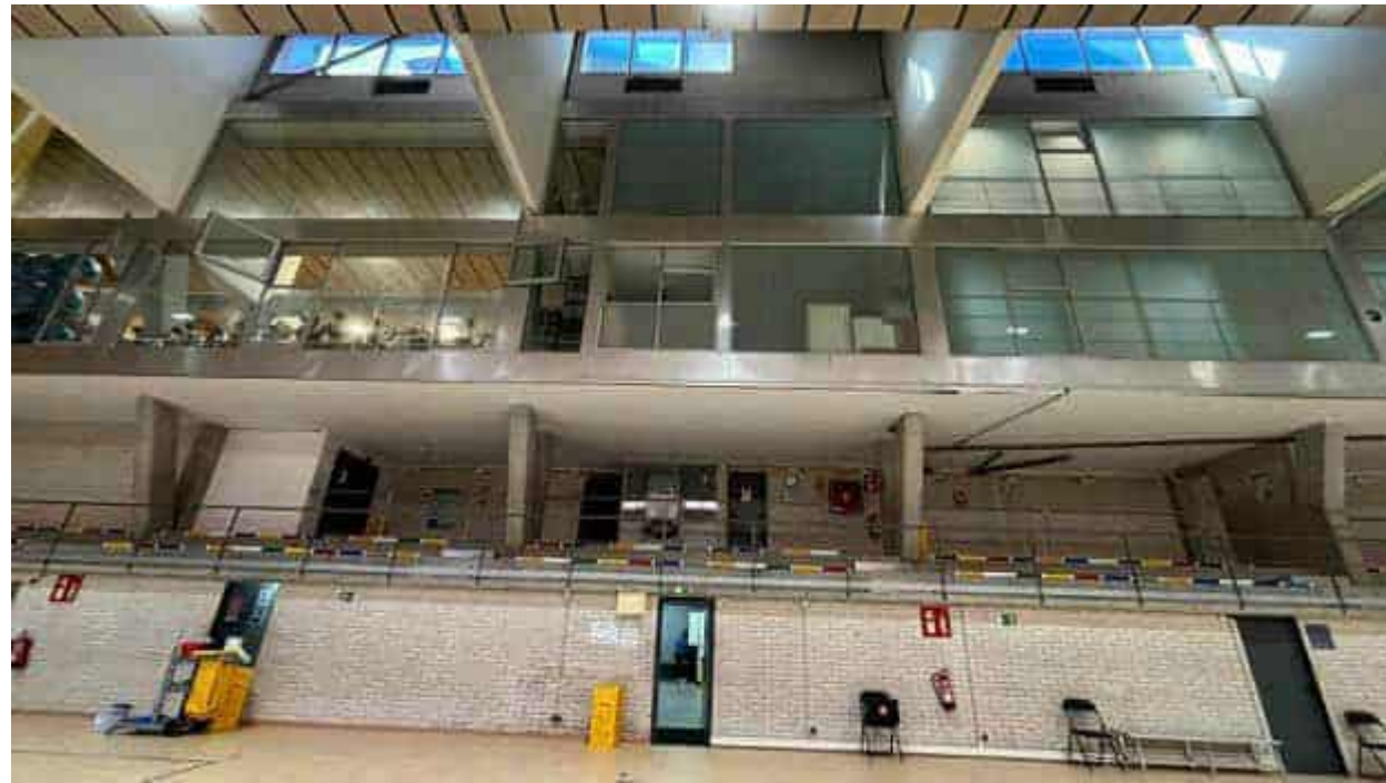
Foto 9: Reixetes d'extracció del sistema de ventilació de la pista poliesportiva de l'Olivera a gran alçada de cota pista
