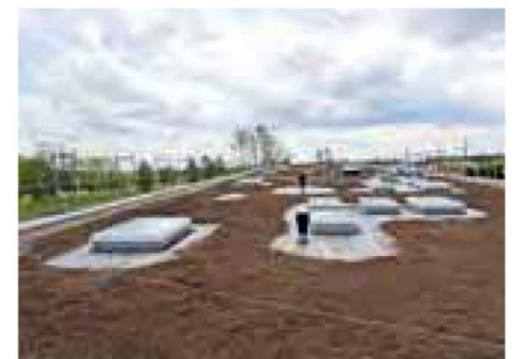
El sustrato Zincoterra "Floral" instalado sobre la cubierta.
