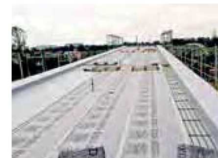
El sistema de cubierta verde con el elemento de drenaje Fixodrain® XD 20 es la base sobre la que se asienta la cubierta biodiversa.
