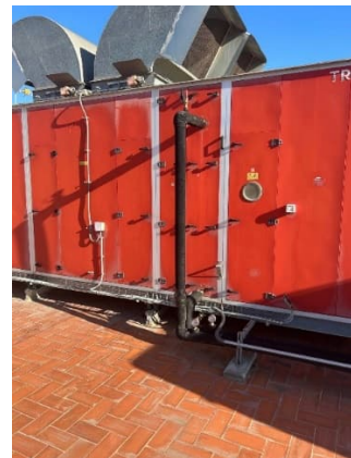
Foto 2: Estat de conservació de la UTA existent
