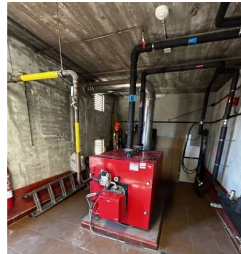
Foto 9. Estat actual sala de calderes
