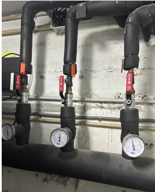
foto 6. Col·lector d'ACS i calefacció existent
