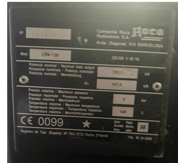
Foto 4. Caldera d'ACS + Calefacció existent actualment en el pavelló
