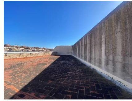
Figura 16: Mur de formigó vist al costat sud de la coberta
