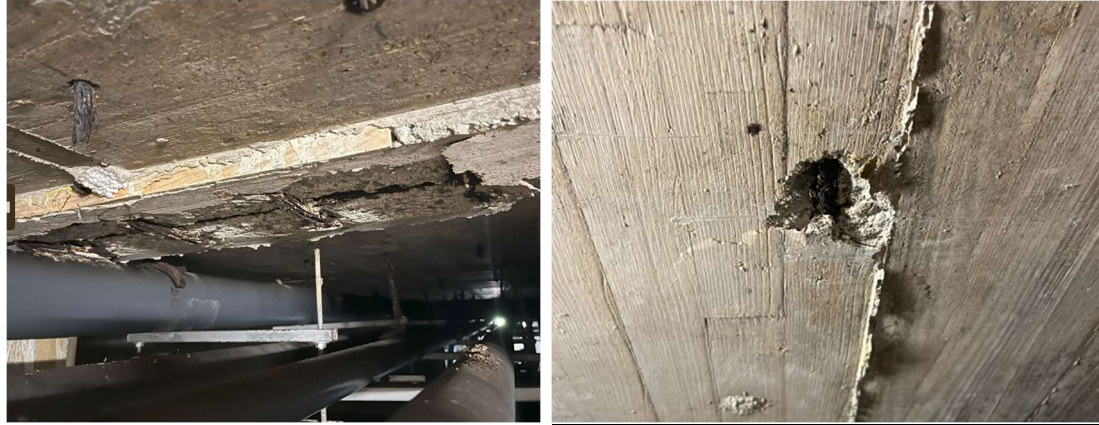
F13 | F14- Estructura en zona dipòsits compensació i maquinaria piscina (grau 3 i grau 2)
