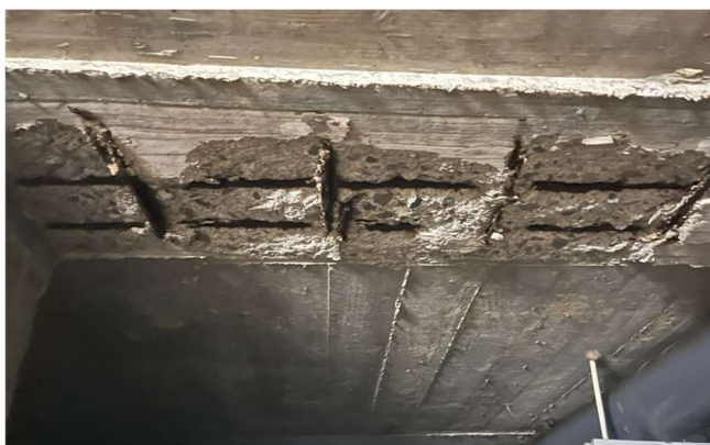
F11 I F12- Estructura en zona dipòsits compensació i maquinaria piscina (grau 3)
