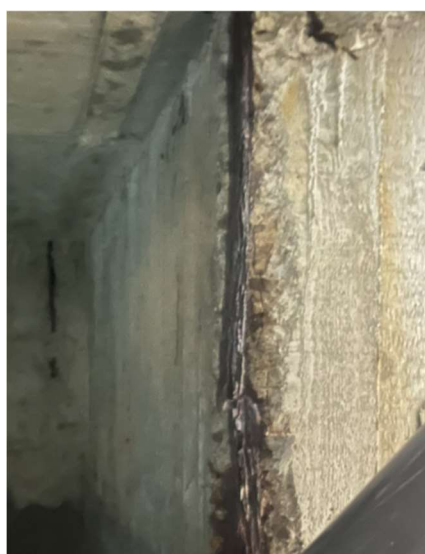
F11 I F12- Estructura en zona dipòsits compensació i maquinaria piscina (grau 3)
