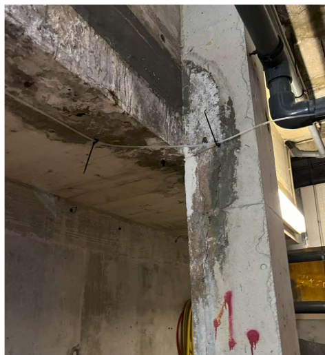
F7 I F8- Estructura en zona dipòsits compensació i maquinaria piscina (grau 2)
