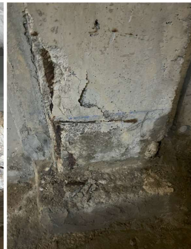
F5 | F6- Estructura en zona dipòsits compensació i maquinària piscina (grau 2)
