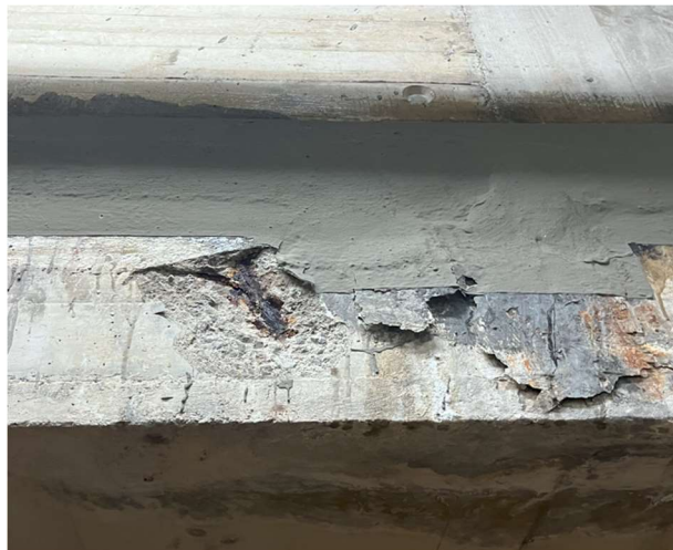
F5 | F6- Estructura en zona dipòsits compensació i maquinària piscina (grau 2)
