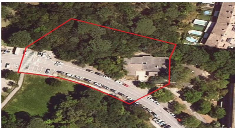
Ambit de les obres i entorn immediat
