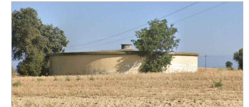
DIPÒSIT REGULADOR 1 DE PALOU
