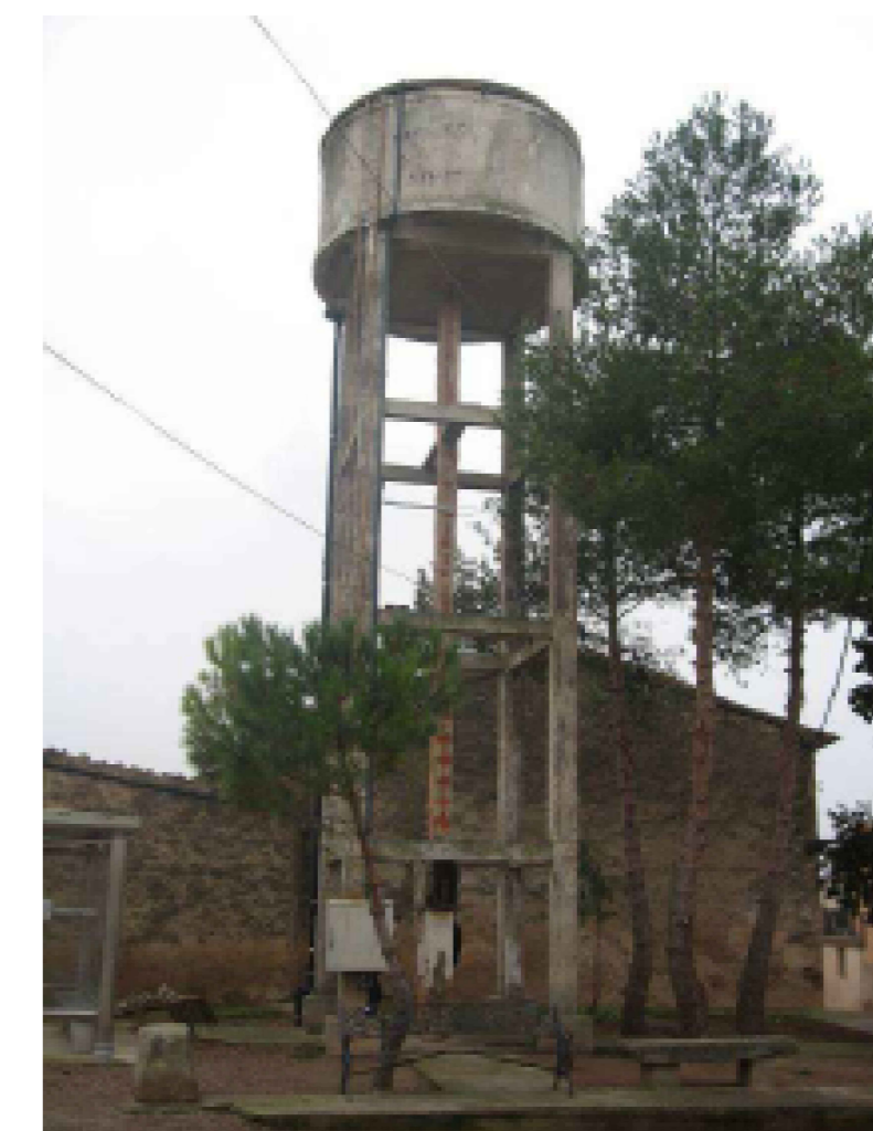
DIPÒSIT ELEVAT DE TORREFETA
