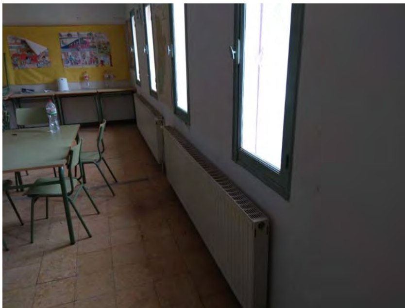
Vista de la fusteria, paviment, parets i calefacció de la sala de la planta primera.
