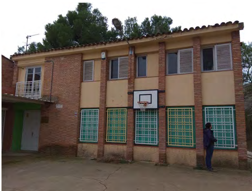
Façana principal (est) edifici antigues escoles
