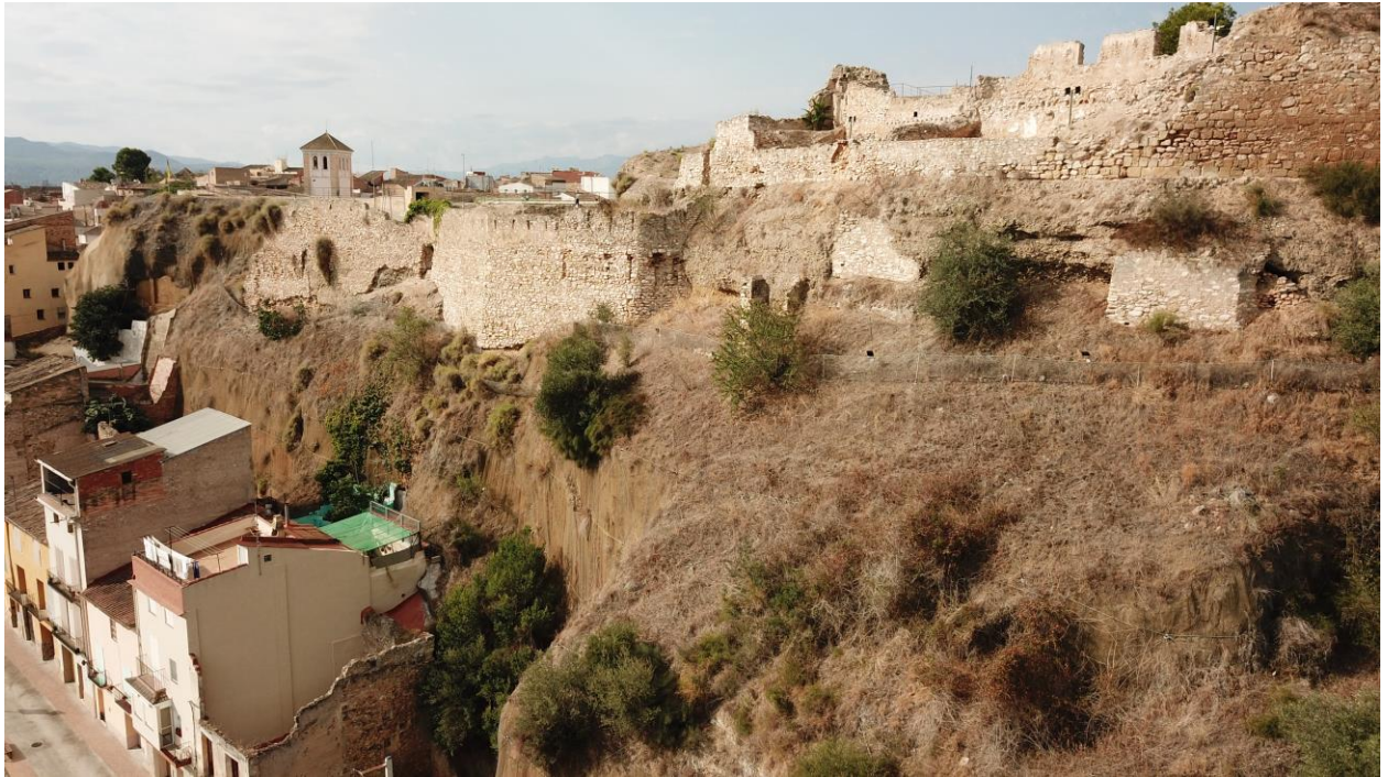
9. Vista del tram de muralla de llevant i visió del talús
