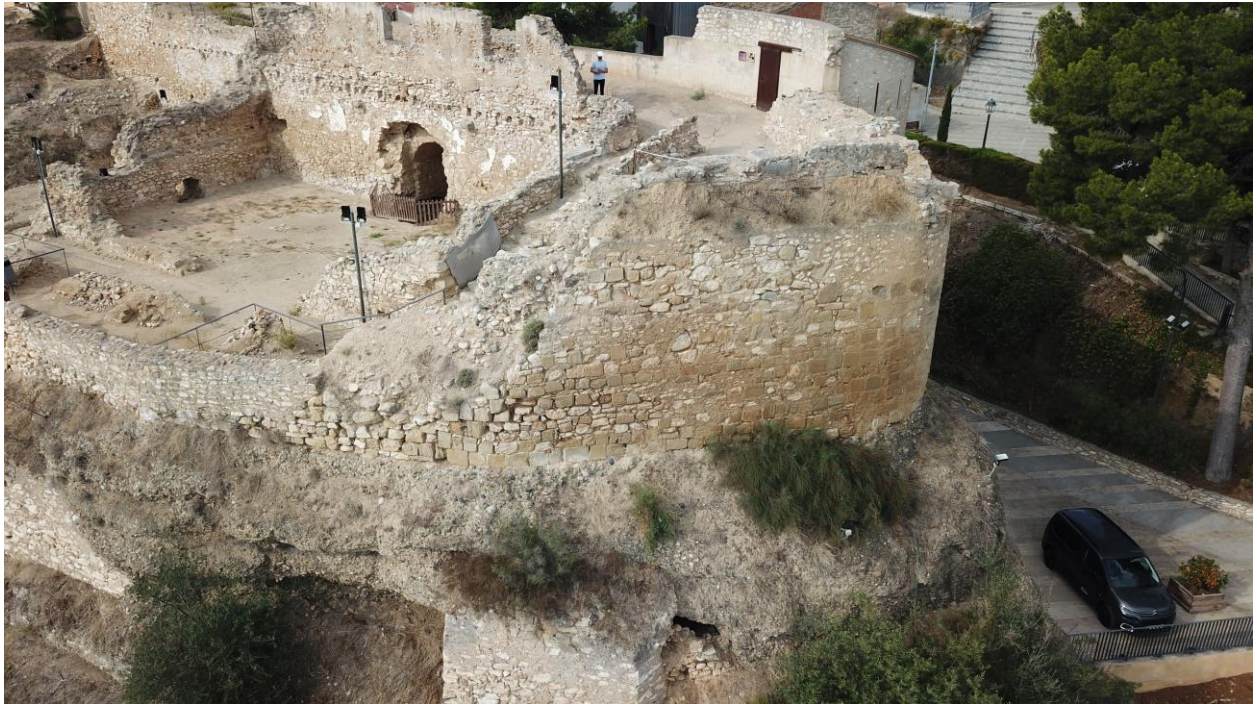
11. Vista de diferents trams de la muralla en planta, zona de la garita enderrocada
