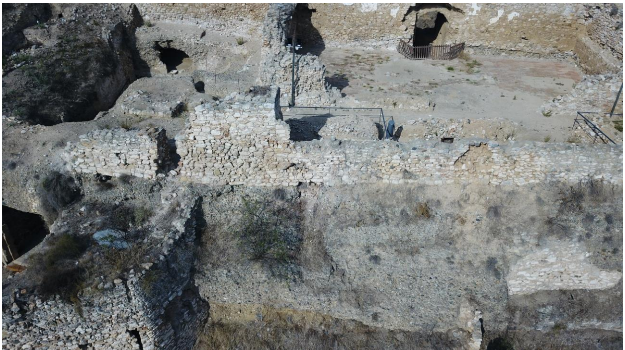
12. Vista de diferents trams de la muralla en planta, zona del recinte superior
