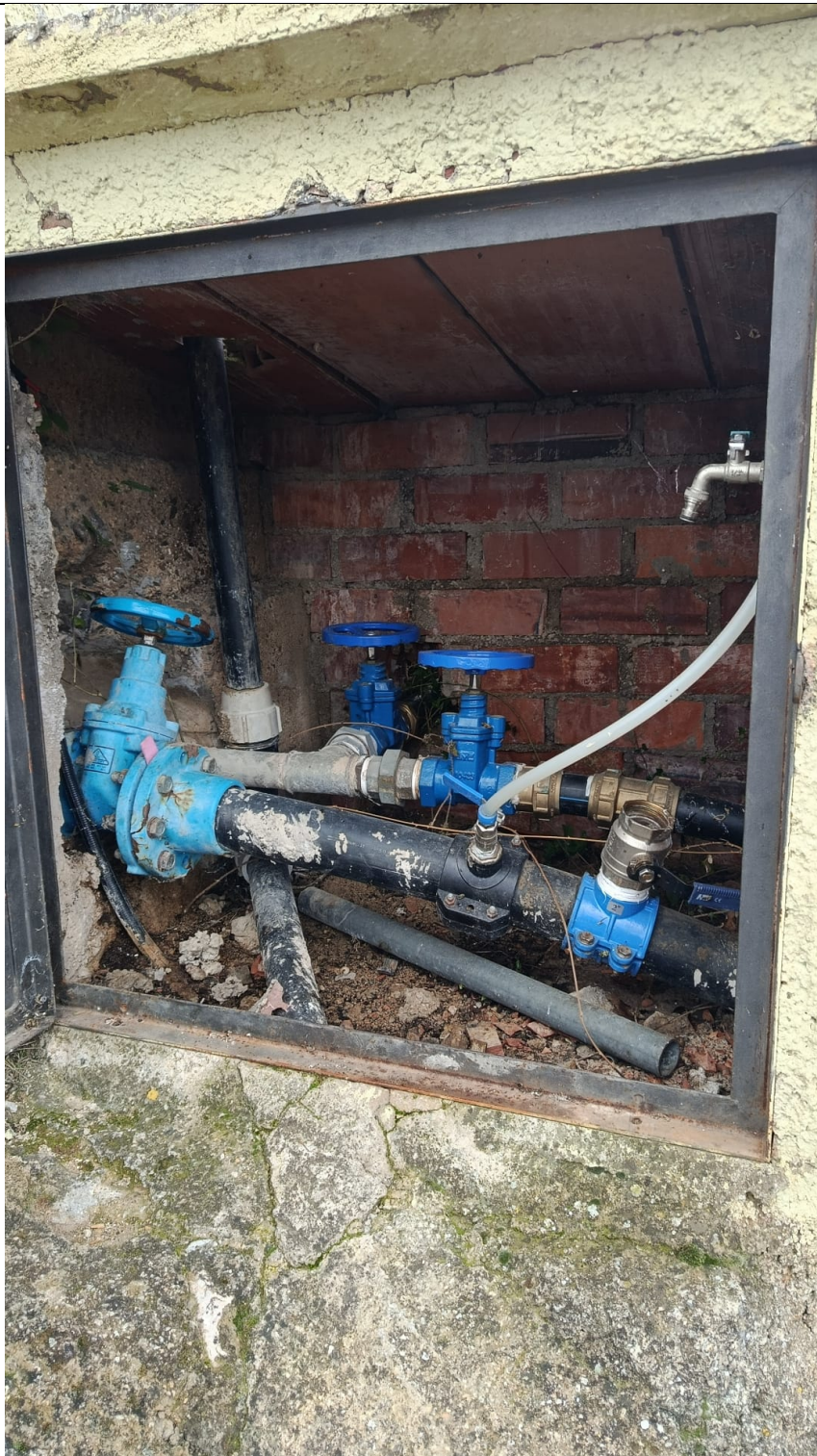
01.01.1 ACTUACIÓ 1 (DIP MONT-RAL) DESAIGUE DN 80 CONVERTIT SORTIDA 1 + ANTIGA SORTIDA 1 DN 50 A CONVERTIR A DESAIGUE + SORTIDA 2 DN 50 +
