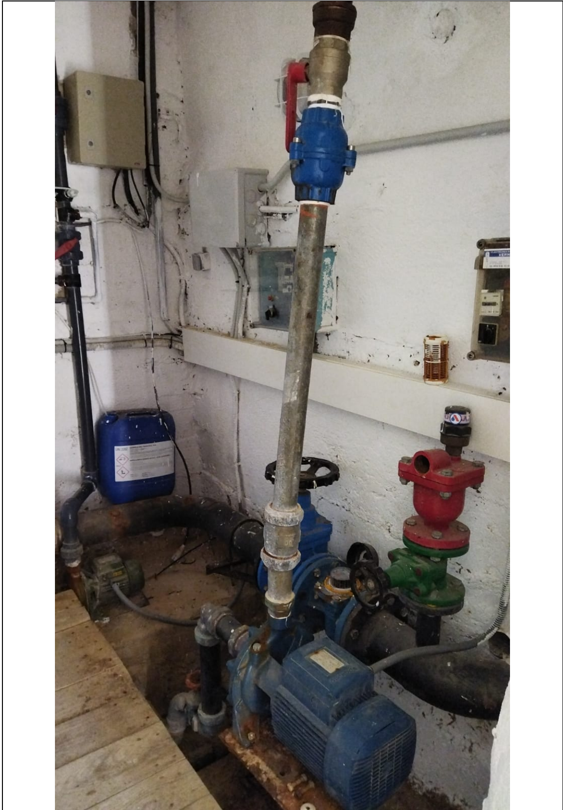
01.02.1 ACTUACIÓ 1 (DIP CAPÇALERA COMPTADOR 1 EIXAMPLE)
