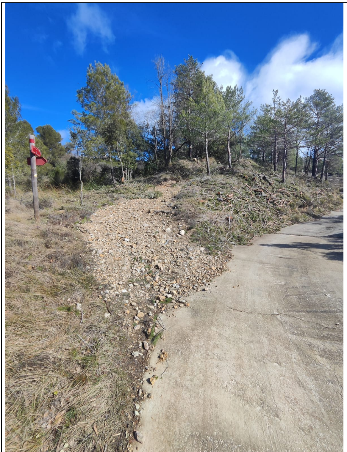
01.03.1 ACTUACIÓ 1 (REDUCTORA R2)
