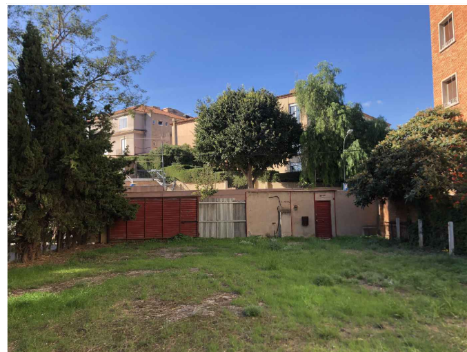
F5 - Mur façana des de l'àmbit
