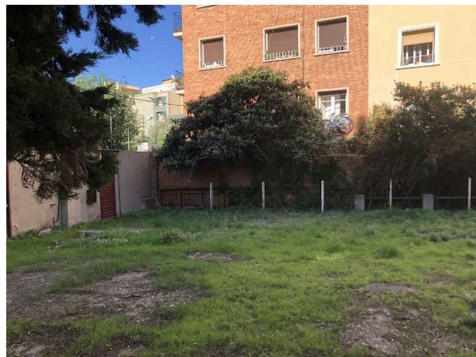
F4 - Alçat nord-oest amb actual construcció pendent d'expropiació
