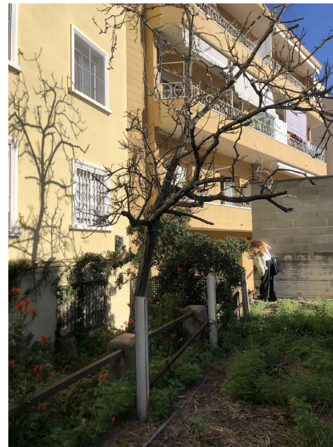
F8 - Desnivell en franja nord-oest
