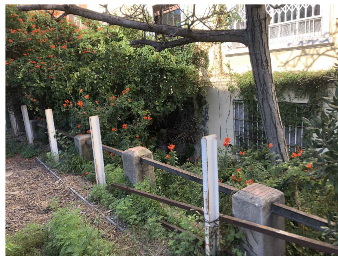
F7 - Desnivell en franja nord-oest
