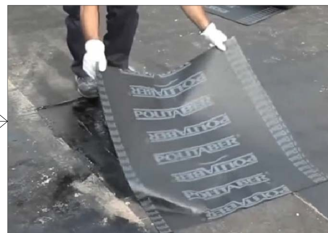
6 - Un cop segellada la peça d'EPDM, es col·locarà una segona làmina que sobrepassi en 10 cm en tot el perímetre de la peça d'EPDM.
