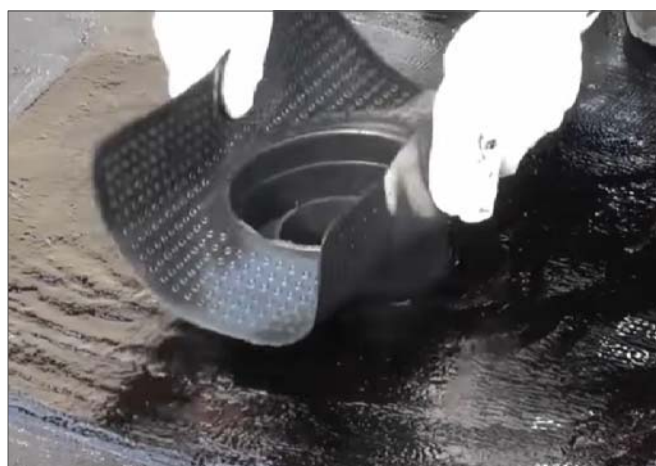
5 - Es col·locarà la bonera d'EPDM i s'escalfarà fins adherir adequadament els punts crítics sobre la làmina prèviament col·locada.
