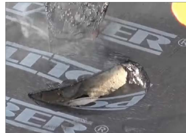
4 - Es procedirà a l'obertura del forat del baixant mitjançant paletí calent i segellant el perímetre de la obertura per part interior.
