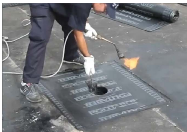
8 - Obertura de forat per a baixant mitjançant paletí calent i segellat del perímetre interior entre làmines.
