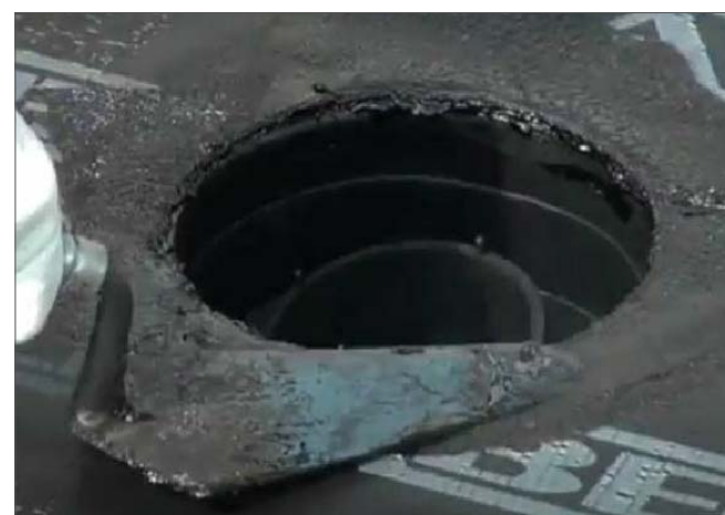
10 - Obertura a la zona de la bonera i execució de la soldadura de la làmina general amb la resta de làmines, a tota la superfície i en el perímetre de l'obertura, mitjançant el paletí en calent.
