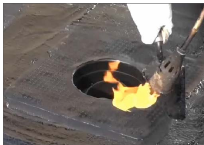
6 - Un cop segellada la peça d'EPDM, es col·locarà una segona làmina que sobrepassi en 10 cm en tot el perímetre de la peça d'EPDM.
