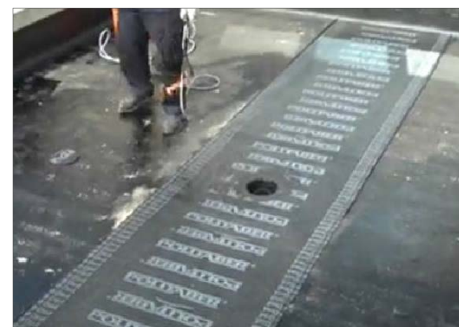
11 - Detall de la obertura del baixant amb les 3 làmines col·locades i soldades entre elles.
