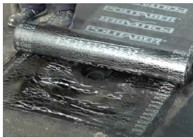
9 - Col·locació de la làmina impermeable general del conjunt de coberta per sobre del detall de bonera executat., soldant en calent.
