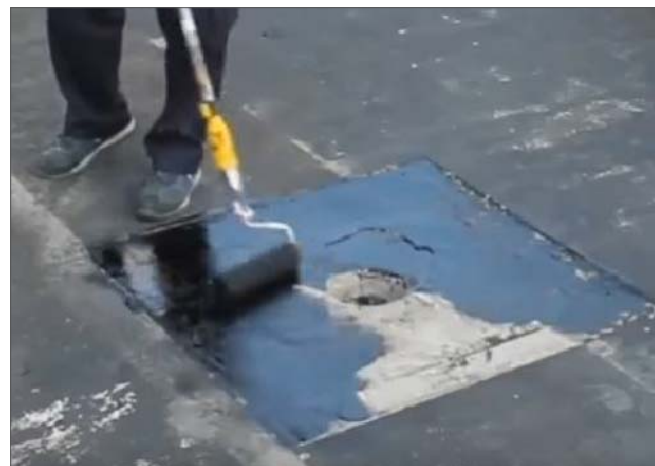
2 - Un cop netejada la superfície, s'aplicarà una capa d'imprimació asfàltica.
