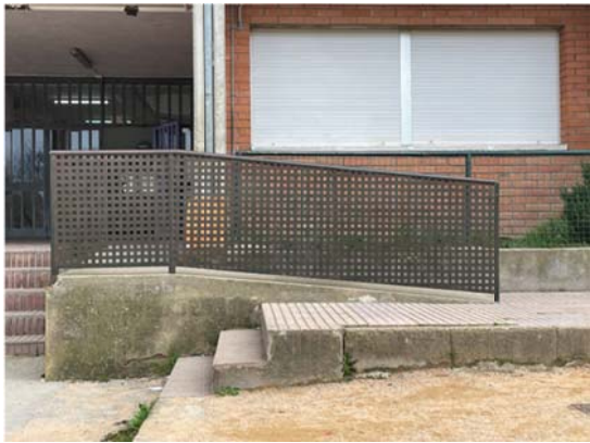
Vista lateral rampa
