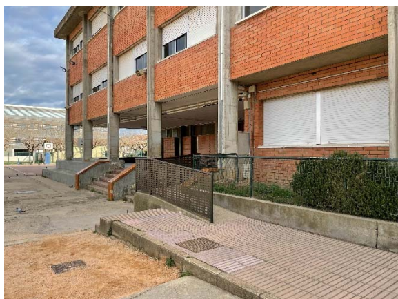
Rampa actual d'accés a l'edifici de primària.
