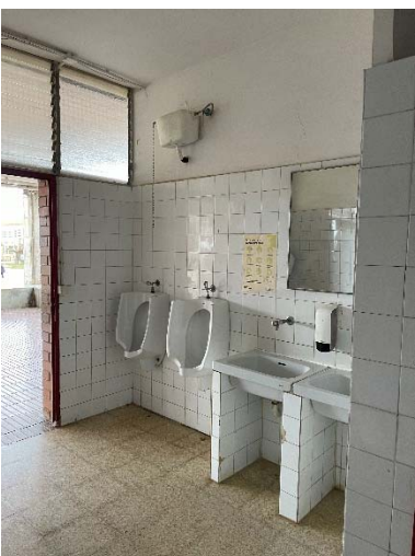
Espai actual lavabos nois.
