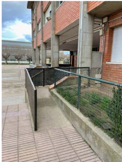
Vista accés inferior rampa
