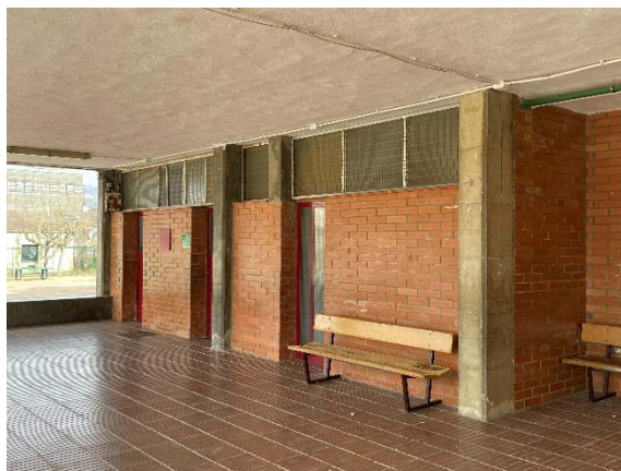
Espai d'accés a lavabos
