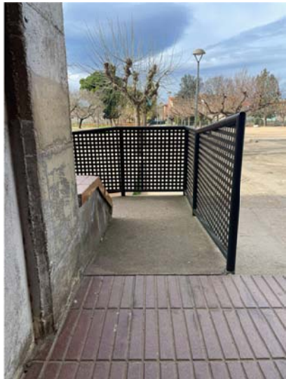
Vista accés superior rampa
