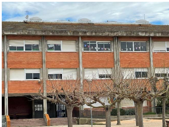
Exterior lluernari coberta
