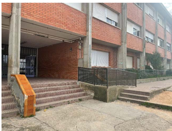
Accés edifici de Primària
