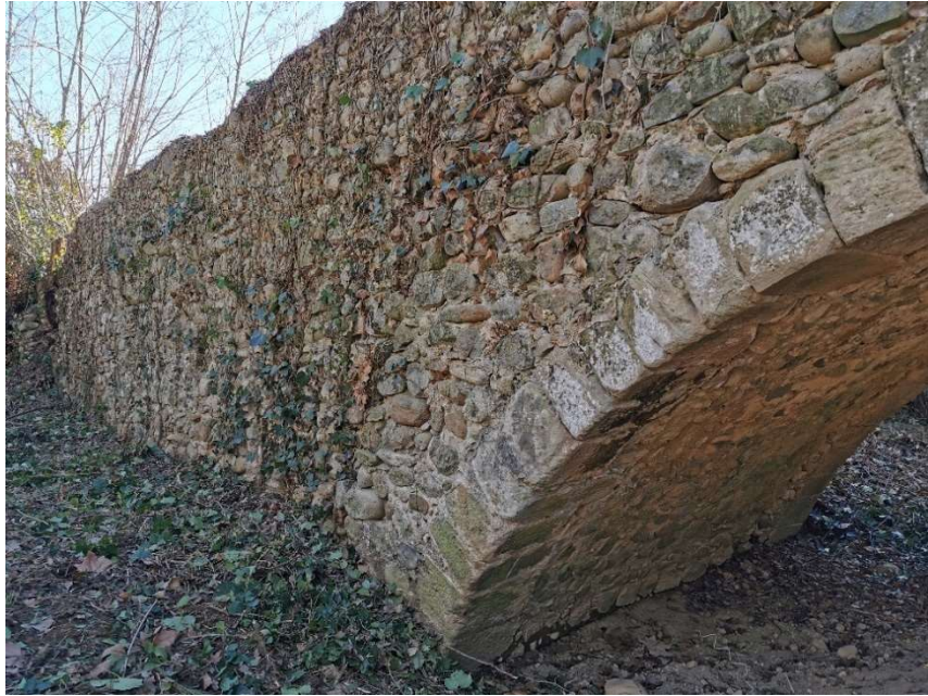
Detall dels murs exteriors del pont
