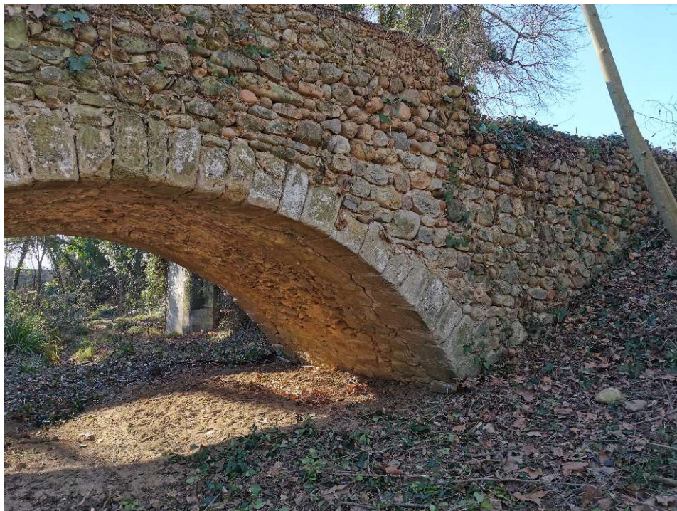
Vista general de la volta inferior
