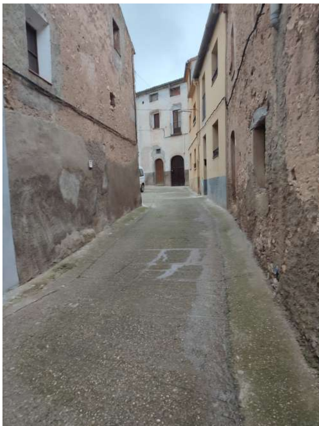
9.- tram C/ Comarques Catalanes
