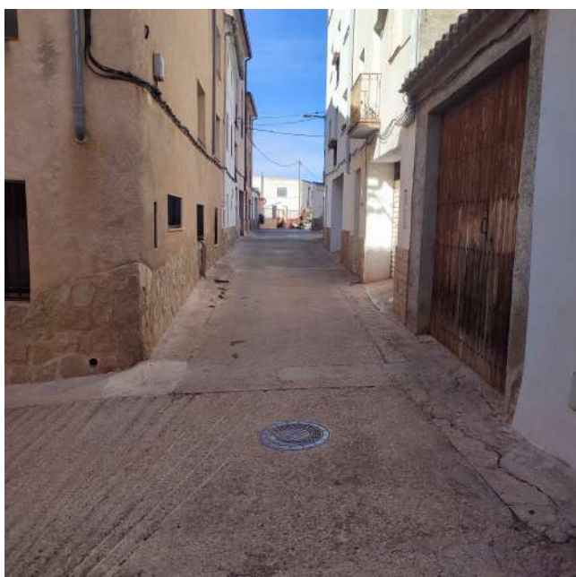
11.- tram C/ Comarques Catalanes
