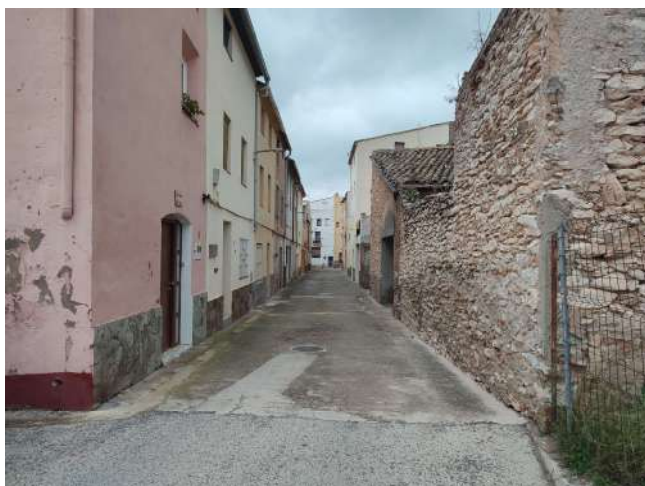
1.- Inici obra tram C/ De la Pau
