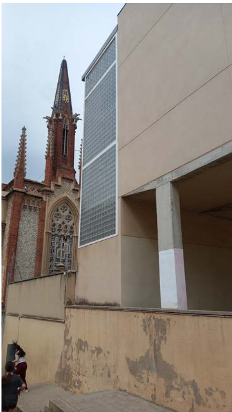
Façana a intervenir
