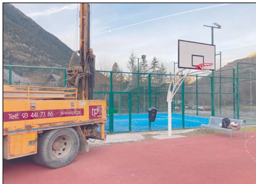
Fotografia 1. Vista general de l'emplaçament de la màquina durant la realització del sondeig a rotació amb bateria contínua S-1.
