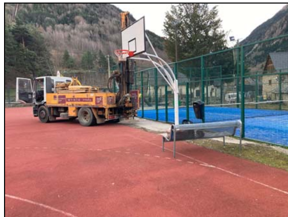
Fotografia 4. Detall de la màquina a rotació utilitzada per a la realització del sondeig.
