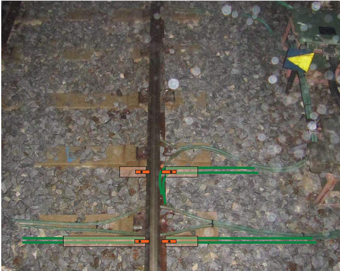
Figura 3.4 Model correcte d'implementació del cablejat
