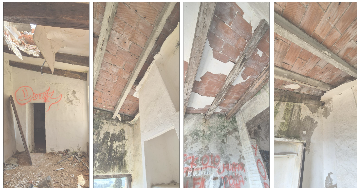
IMATGES ESTAT ACTUAL ESTRUCTURA
