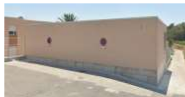
Central de producció de fred i calor
