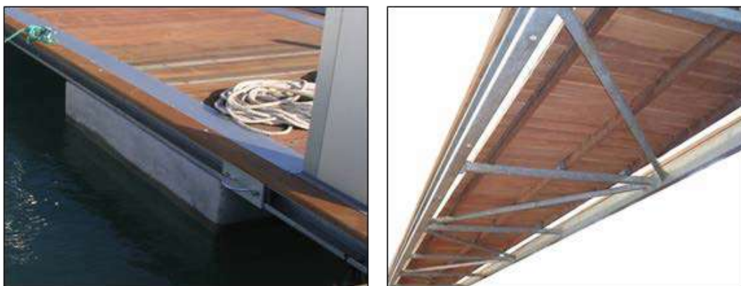
Imatge 1. Detall tipus estructura
