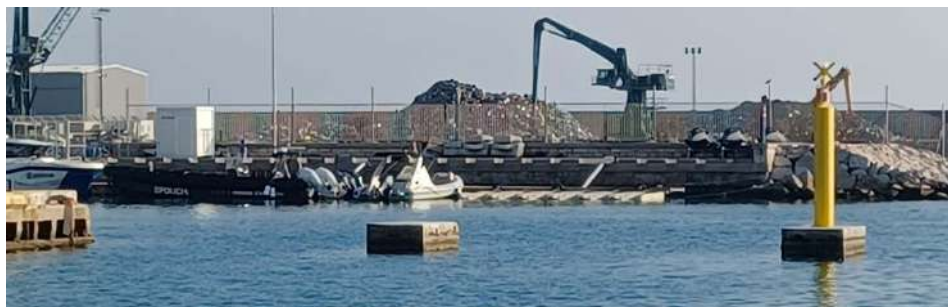
Fotos 2. Detall piles aïllades existents
