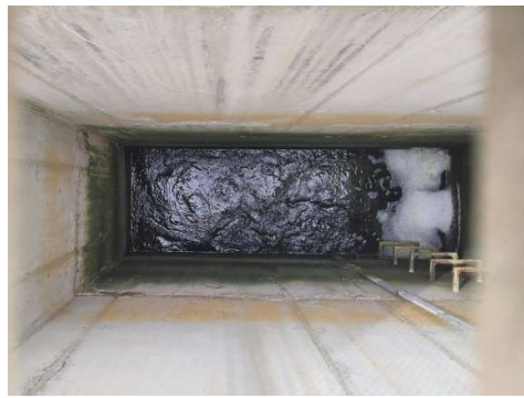
Vista interior arqueta sobreixidor
