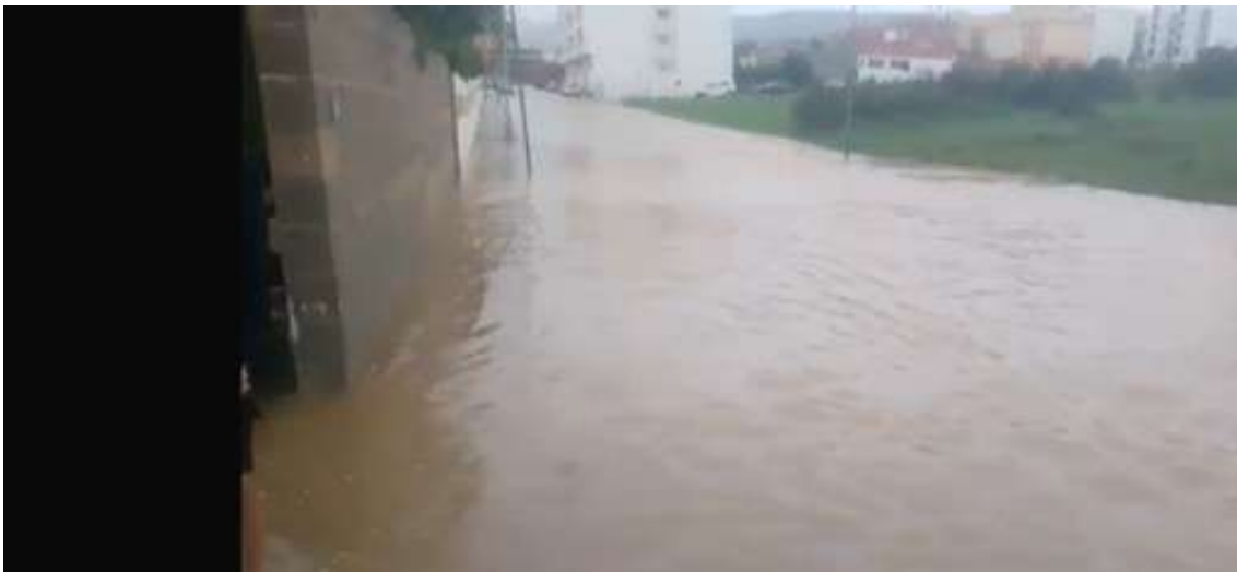
Imatge 8. Inundació carrer Barranquet degut al trencament del col·lector DN1000 existent.
